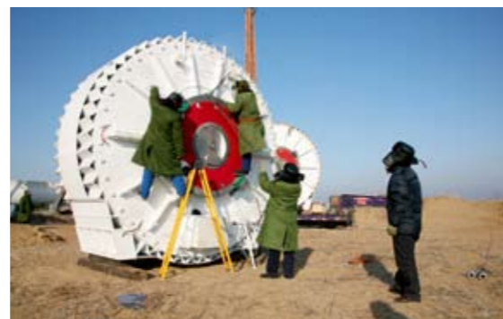
两兆瓦直驱风力发电机安装现场
